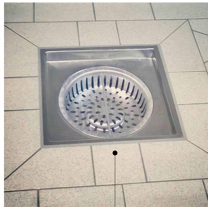
Detail polaganja keramike: Keramiko v oddaljenosti 1m od talne rešetke je potrebno položiti s padcem 1% proti talni rešetki.
